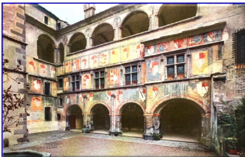
parete della scala (H) e parete d'ingresso (I)
